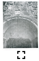
Fig. 47: Portal - detaliu, Arhiva Drăguț
