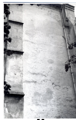
Fig. 3: Contrafort-fatada de nord, sec. XV, Arhiva Drăguț
