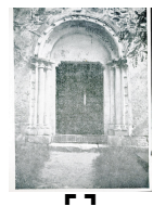
Fig. 46: Portal, Arhiva Drăguț
